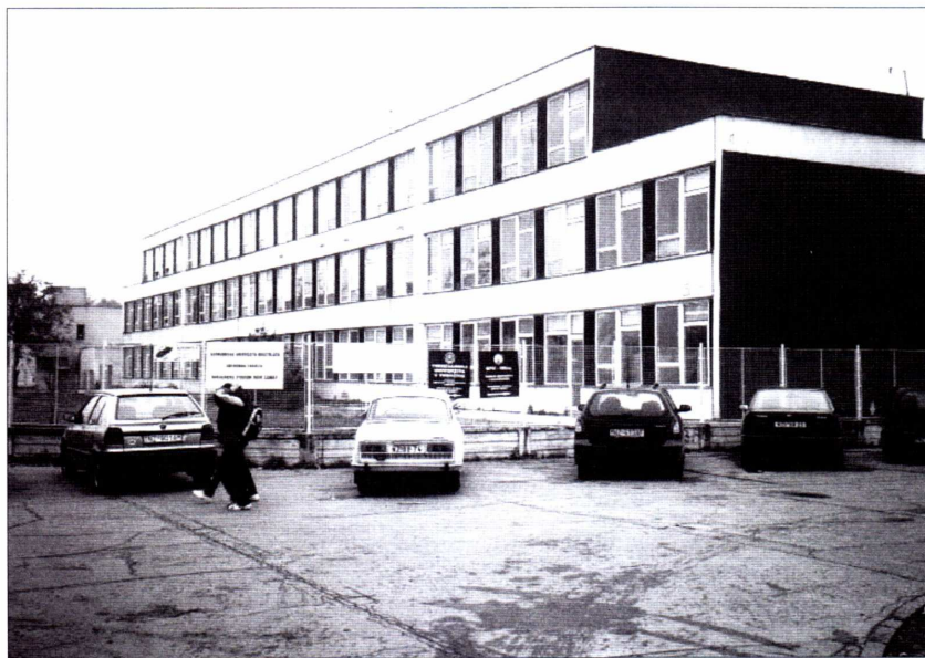
A Letomostie (Nyárhíd) utcai épületünk
